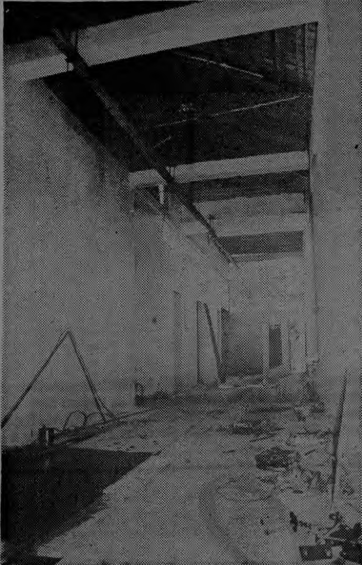
terior del matadero. Nótese la altura que tiene y los rieles que están instalados en el centro (arriba del edificio) para transportar la carne de modo que esta no toque el suelo. También fueron instaladas a ambos lados de sus paredes luces fluorescentes para una mejor visibilidad de los operarios. (Foto Córdoba).
